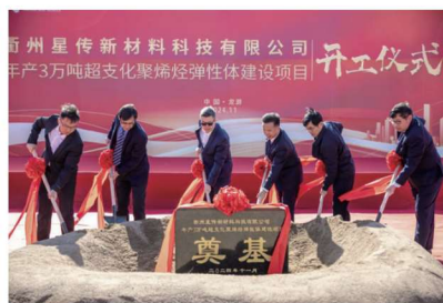
3万吨/年H-POE工业化示范性 生产线开工建设现场
