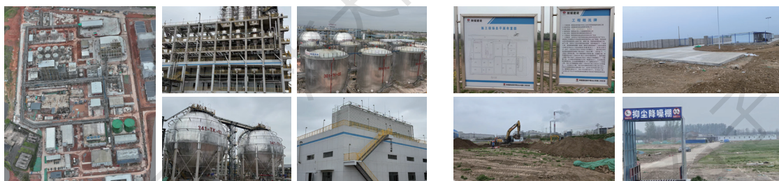
8万吨H-POE（一期3万吨+二期5万吨）/年生产线建设现场
