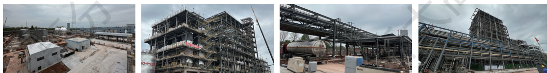
10万吨H-POE/年生产线建设现场
